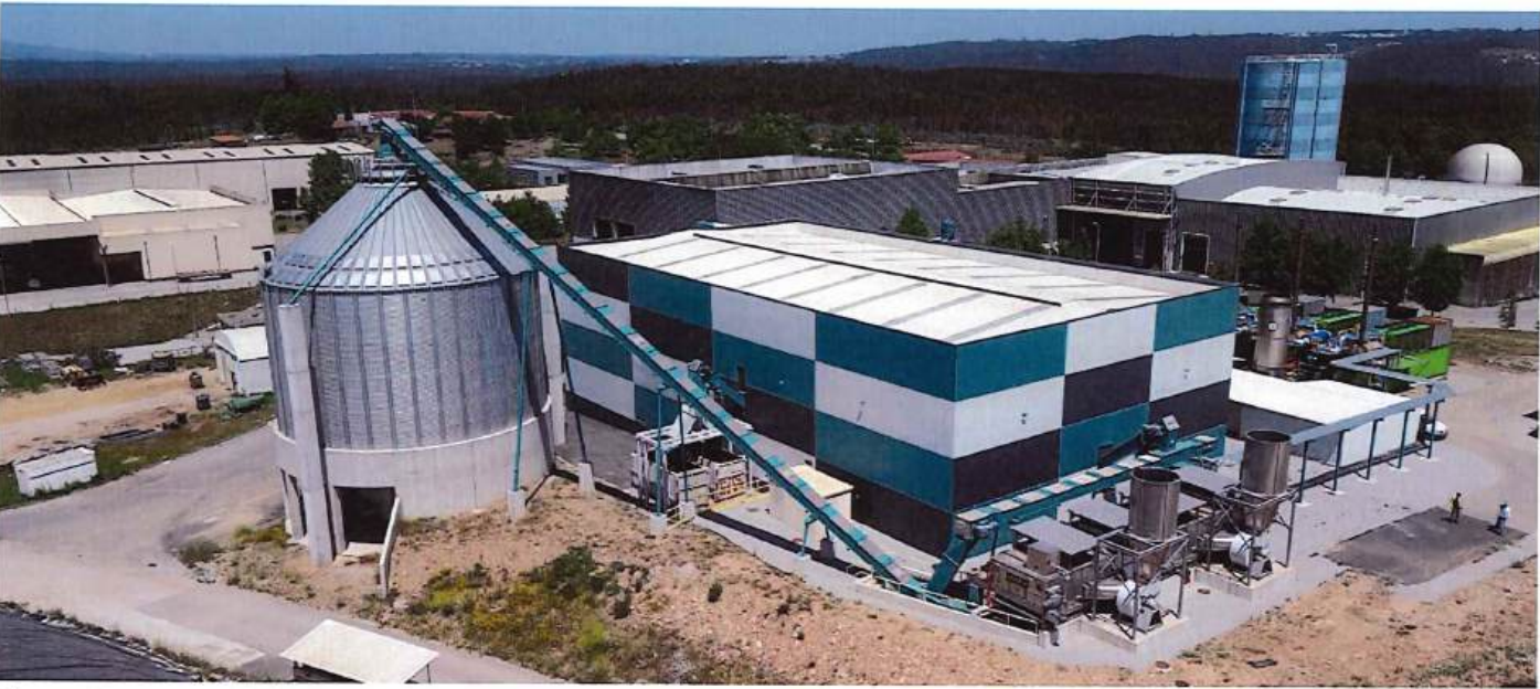
Figura 23 - Central de CDR - Visão Exterior
