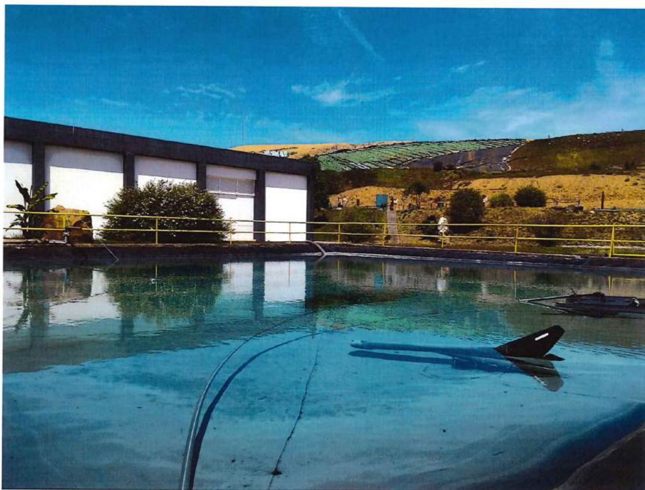
Figura 28 - Lagoa de água tratada
