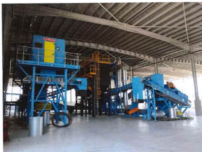
Figura 21 - Parque de Compostagem - Visão Interior
