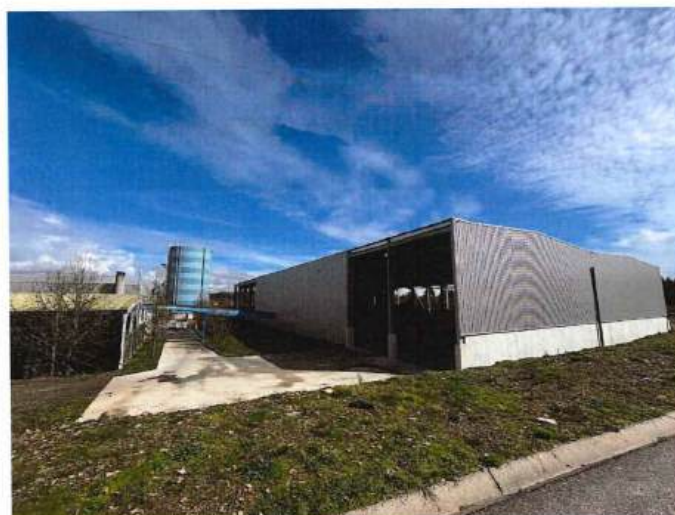
Figura 22 - Parque de Compostagem - Visão Exterior
