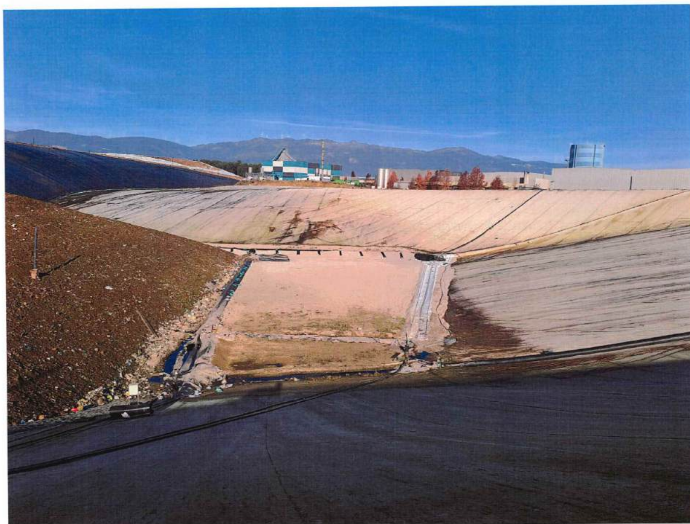
Figura 27 - Vista parcial da nova célula
